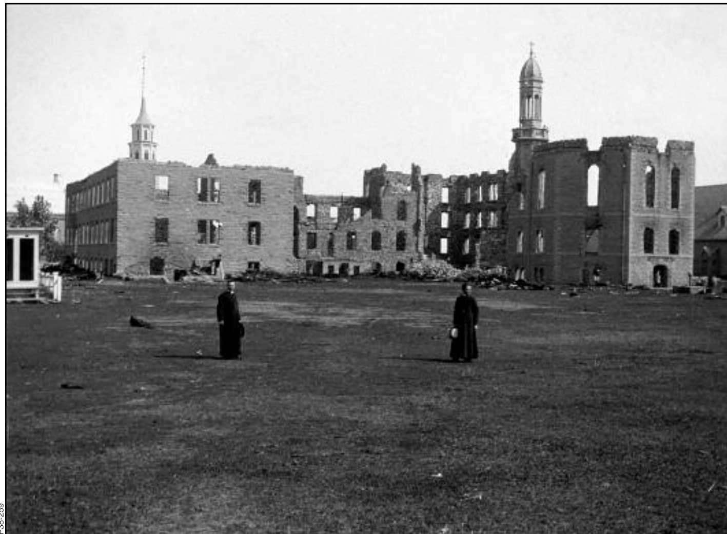
Des parois vides, c'est tout ce qui reste du collège de Caraquet après l'incendie de 1915.
