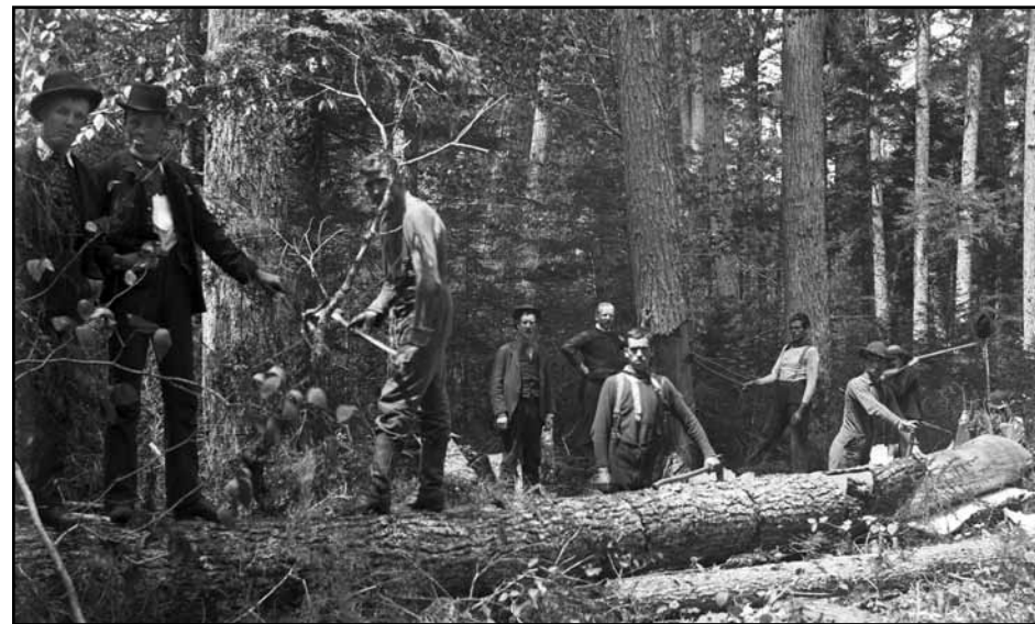
Hommes dépouillant des pruches de leur écorce pour le compte de l'usine de tanin des Miller, v. 1900. Ceux qui étaient employés à ce travail étaient appelés écorceurs (spudders) et utilisaient un fer appelé écorçoïr (spud) pour exécuter leur tâche.
