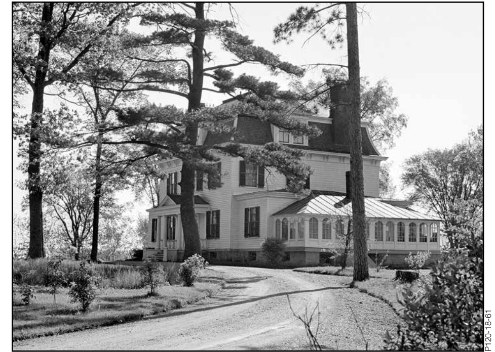
Elmcroft Place, à Fredericton, résidence d'Henry George Ketchum, rénoverée et agrandie par le charpentier Charles Moffitt en 1871 avec l'ajout d'un toit en mansarde et d'une serre.
