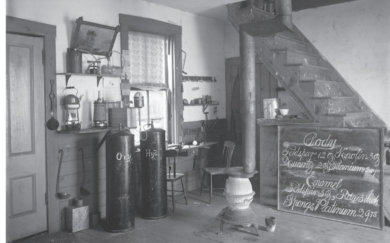
Le studio de Warren M. Sharp à Sussex avec de grands réservoirs noirs d'oxygène et d'hydrogène utilisés afin de produire de la lumière pour un projecteur. (P33-267)
